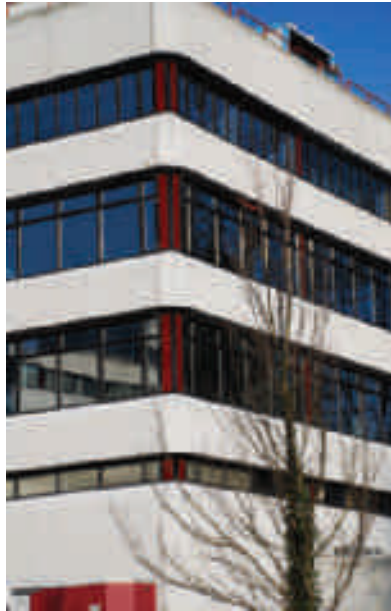
Foto links: Aan de andere kant van het pand blijkt toch een noodoverlaat te zijn.
